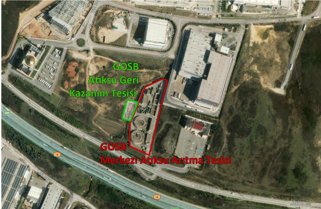
Şekil 20. GOSB Merkezi Atıksu Arıtma Tesisi ve Atıksu Geri Kazanım ve Yeniden Kullanım Tesisi Uydu Görüntüsü
